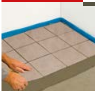
Укладка керамической плитки
