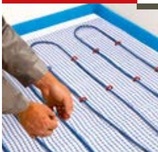
Укладка греющего кабеля
