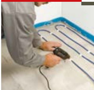
Укладка греющего кабеля
