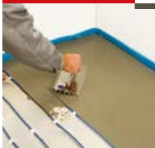
Нанесение выравнивающей стяжки
