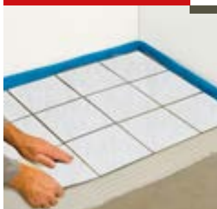
Укладка плитки из натурального камня
